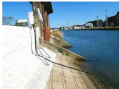
【圧力式水位計設置例】
