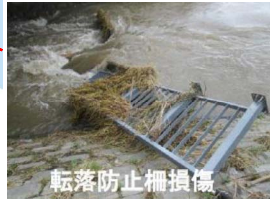
右: 転落防止柵損傷 雲出川 左岸8.2k
