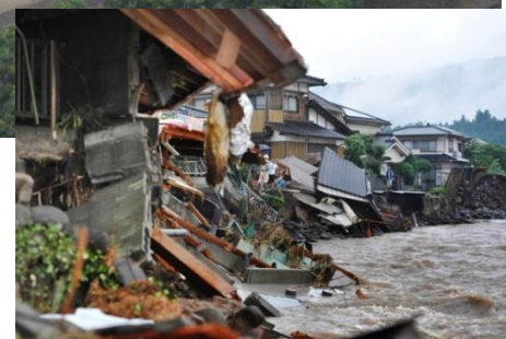
河岸侵食により家屋倒壊した状況
