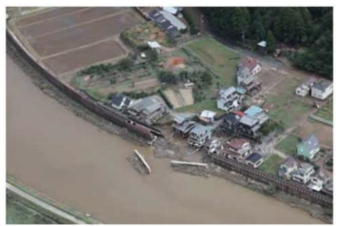
平成23年台風12号 熊野川高岡地区の輪中堤の倒壊
