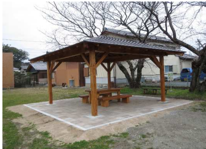
王中島地区工事
