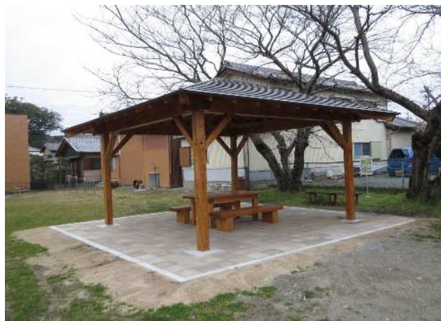
王中島地区工事
