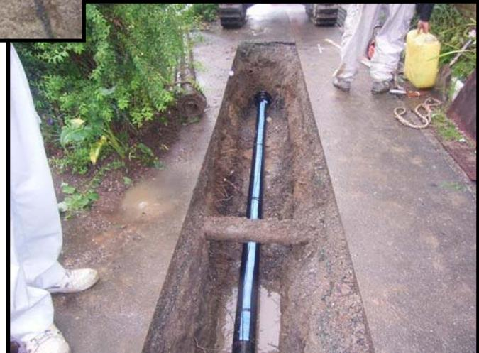
◇ 老朽管撤去状況(上段)および新設管路布設状況(下段) ◇
