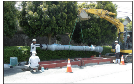
【配水本管布設替工事】
