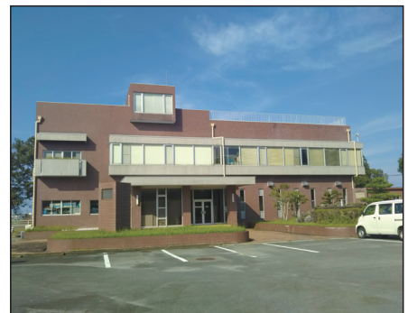
【中須水源地水道管理センター】
