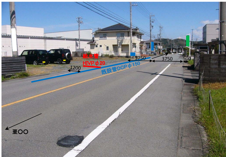
3 施工前の写真
