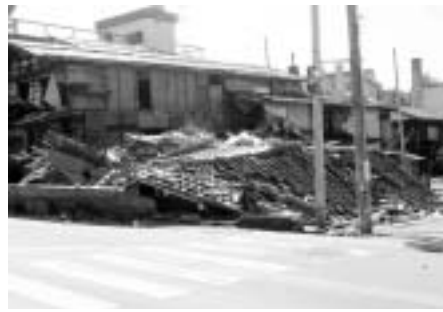
新潟県中越地震（2004年10月23日発生）での住宅被害状況（撮影：三重県）
