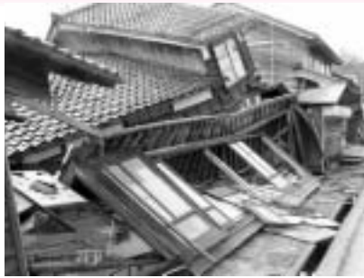
能登半島地震（2007年3月25日発生）での住宅被害状況（撮影：三重県）
