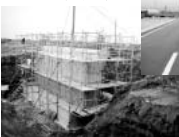
施工中の市道柏東大淀線(橋台)
