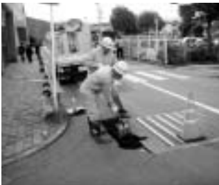
パトロール時に発見した 道路段差の補修作業
