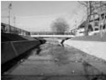
拡幅された桧尻川支川
