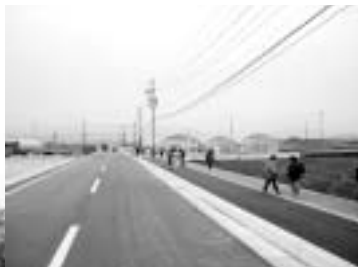
一部完成した市道小俣20号線
