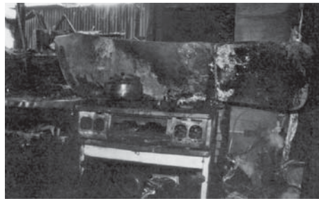
こんろが出火原因となった火災 (消防庁提供)
