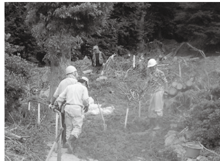
裏山から流出した土砂の除去作業
