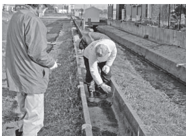
用水路の補修
