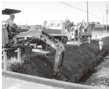
農道排水路のり面の張りコンクリート化
