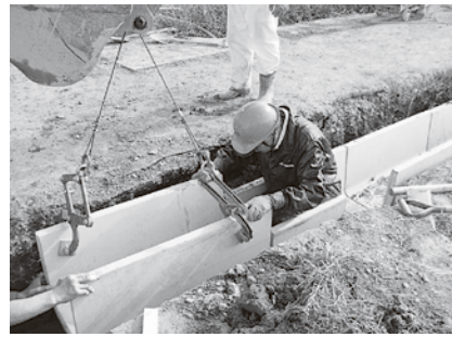
用水路の長寿命化工事
