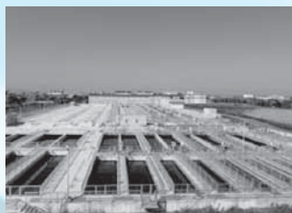
宮川浄化センター
