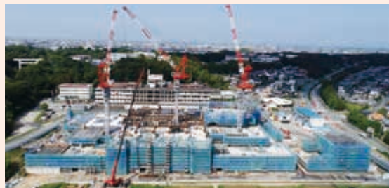
新病院建設中の様子(平成29年9月撮影)
