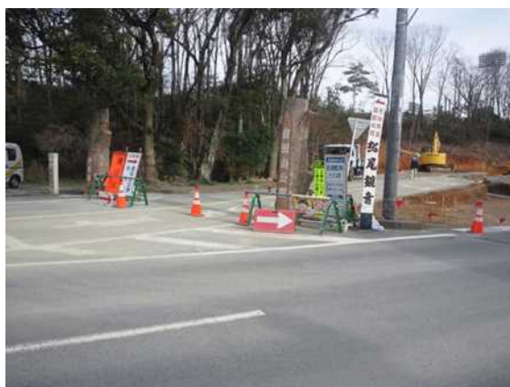
写真－1 現状進入路
