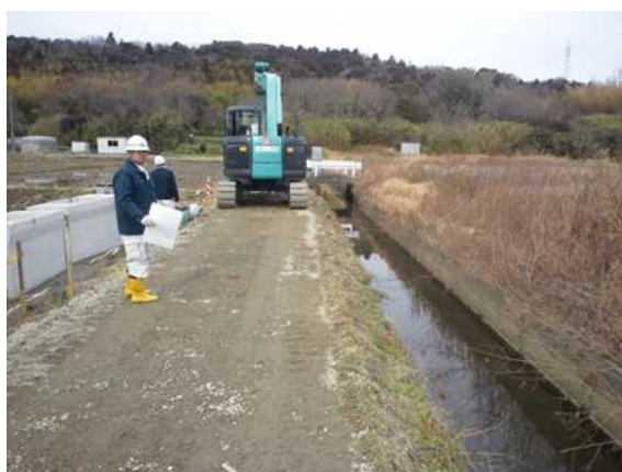
写真－1 自由勾配側溝据付工 （水路沿い道路内へ据付－重機の奥から据付中）
