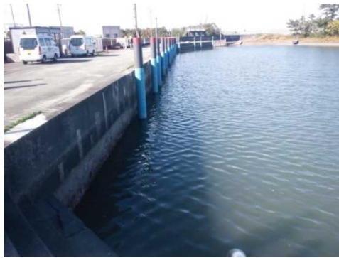
写真－1 係留杭の補修状況（浮棧橋は調査のため陸揚げされている）
