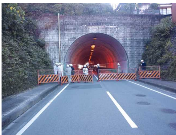
写真－1 秋葉山トンネル入口付近
