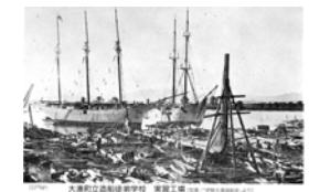
大湊町立造船徒弟学校実習工場
