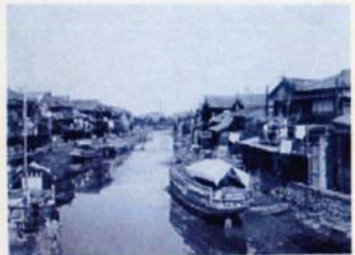
昭和9年頃 中橋より北新橋
