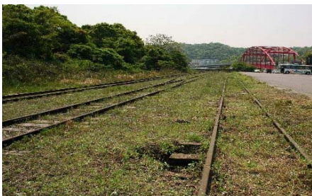
整地前の様子
