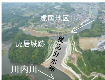
川内川下流から見た虎居地区
