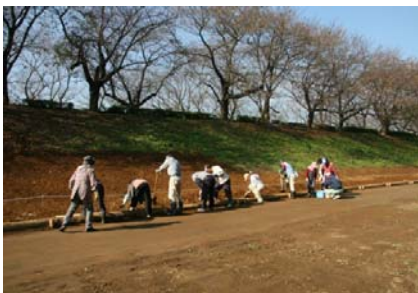
法面の土留め作業、法面を整地し法面は崩れやすいため、土留めを実施。
