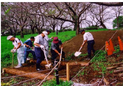
階段を作っている様子。会の設立当時、階段はなく、ここを訪れる来園者の利便性を考え階段を設置。
