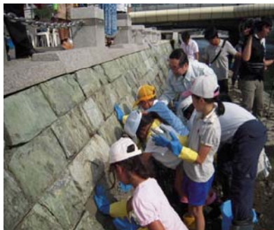
モルタルを塗った箇所への青石護岸の張り付け
