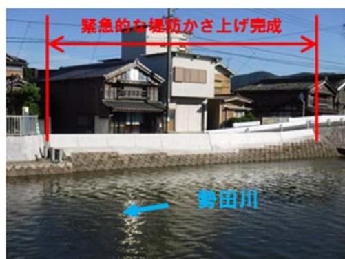
図 2-2 特殊堤防設置状況（北新橋右岸下流）
