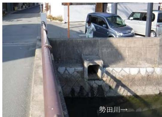
図 2-5 逆流防止フラップ弁設置予定の排水管
