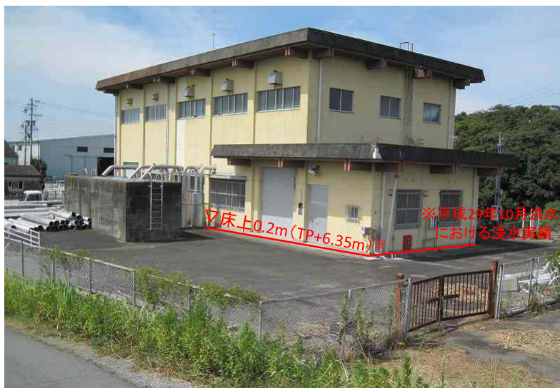
図 3-7 汁谷川排水機場
