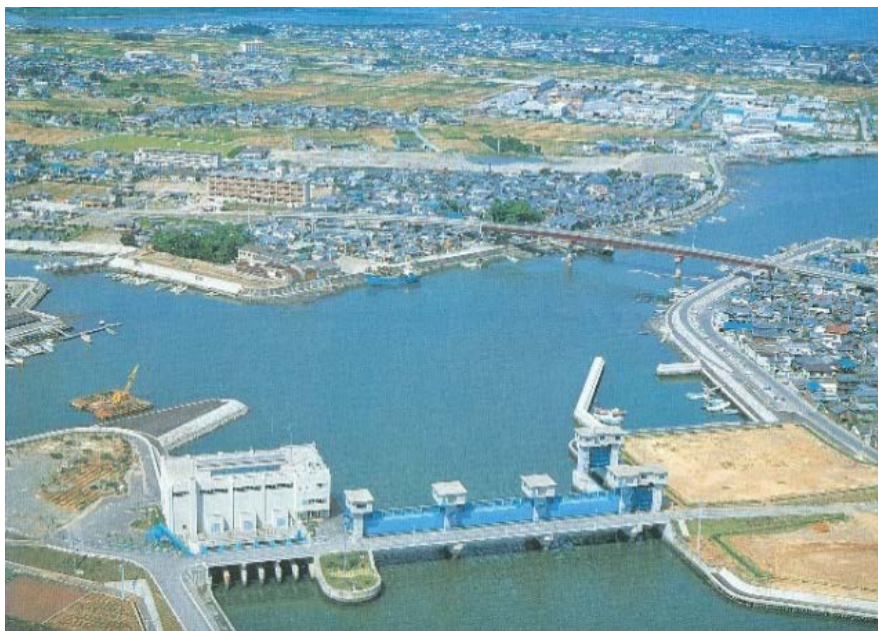
図 2-4 勢田川排水機場ポンプ増強
