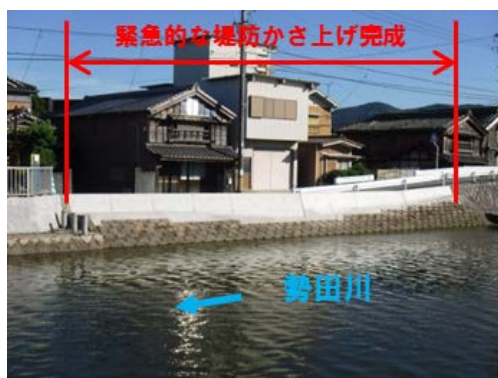
図 2-2 特殊堤防設置状況（北新橋右岸下流）
