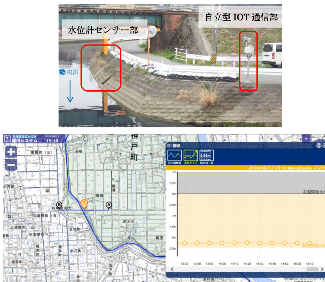
図 2-11 危機管理型水位計（勢田川左岸 4.6k 付近）と運用システムの表示イメージ
