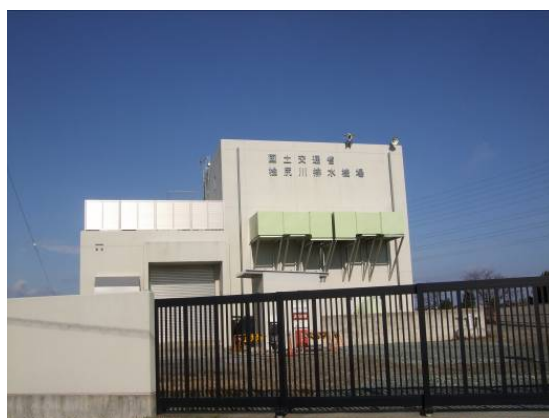
図 2-6 桧尻川排水機場ポンプ増強
