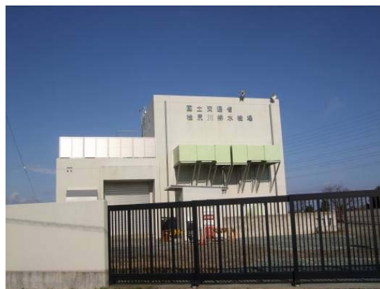
13 14 図 2-6 桧尻川排水機場ポンプ増強
