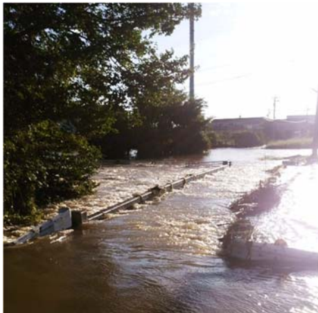
(a) 小俣町 (落田橋)
