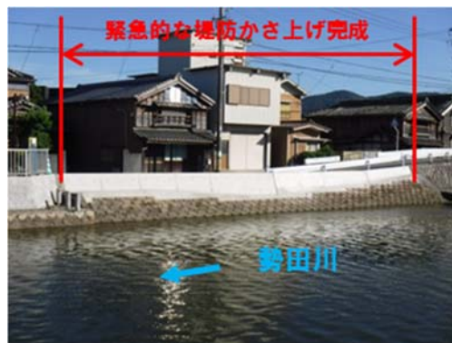
図 2-2 特殊堤防設置状況（北新橋右岸下流）
