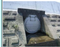
逆流防止フラップ弁の設置（伊勢市）
