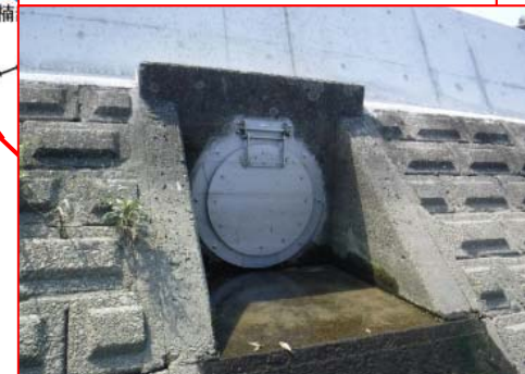
【伊勢市】逆流防止フラップ弁設置 （勢田川 7箇所、H30年8月完了）
