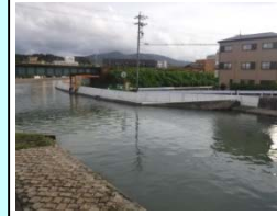
緊急的な堤防かさ上げ（国）
