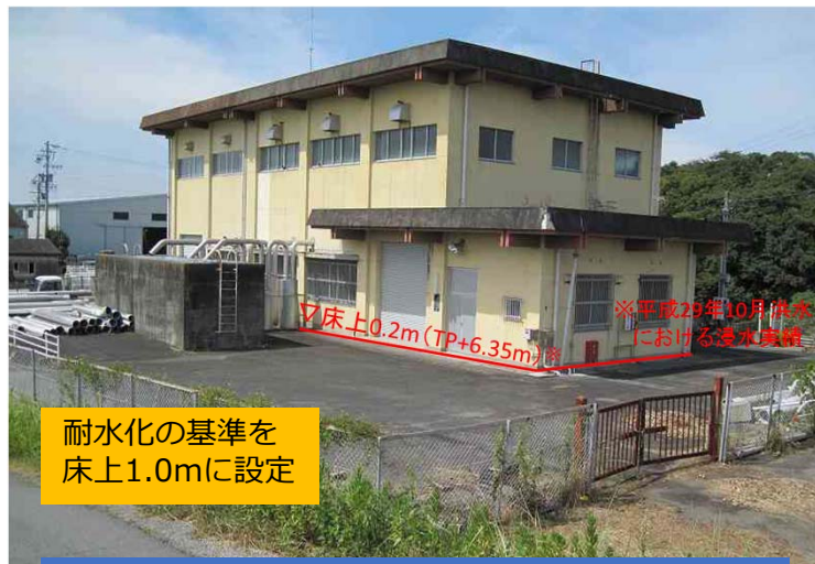
汁谷川排水機場
