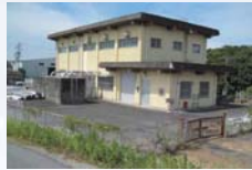
汁谷川排水機場
