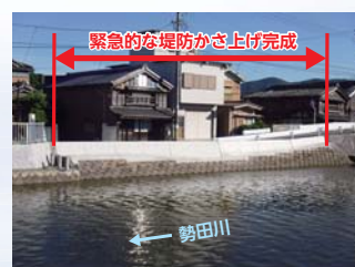
特殊堤防設置状況 (北新橋右岸下流)
