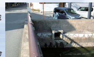
逆流防止フラップ弁設置予定の排水管
