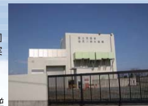
桧尻川排水機場ポンプ増強
