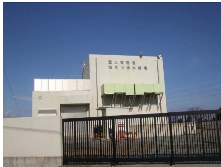
桧尻川排水機場
