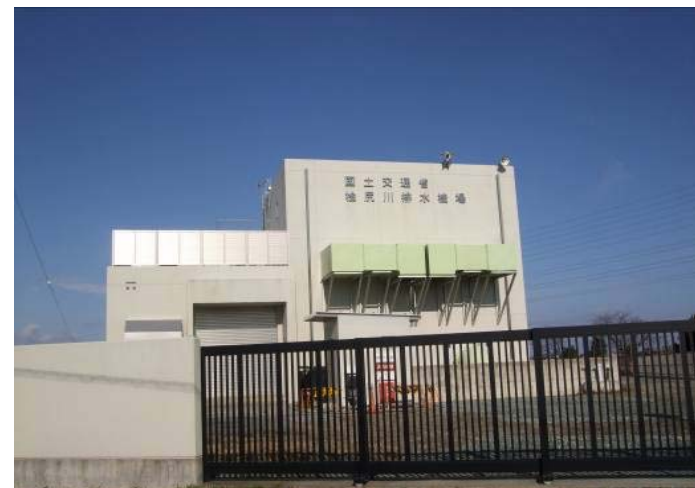
桧尻川排水機場
