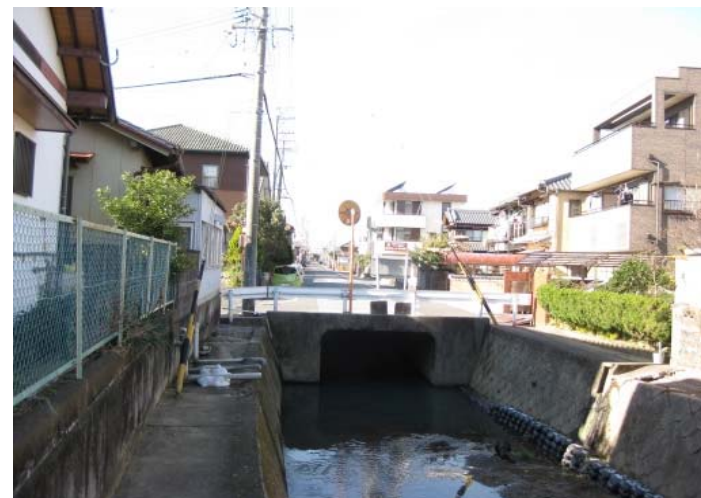
雨水幹線排水路の整備
