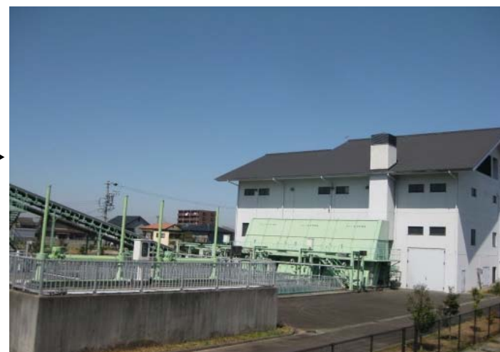
黒瀬ポンプ場の増強
