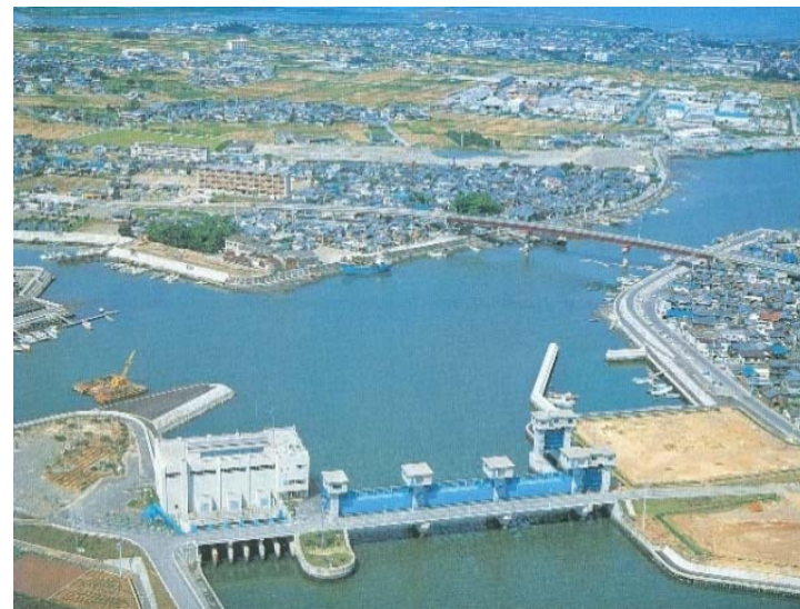
勢田川排水機場
