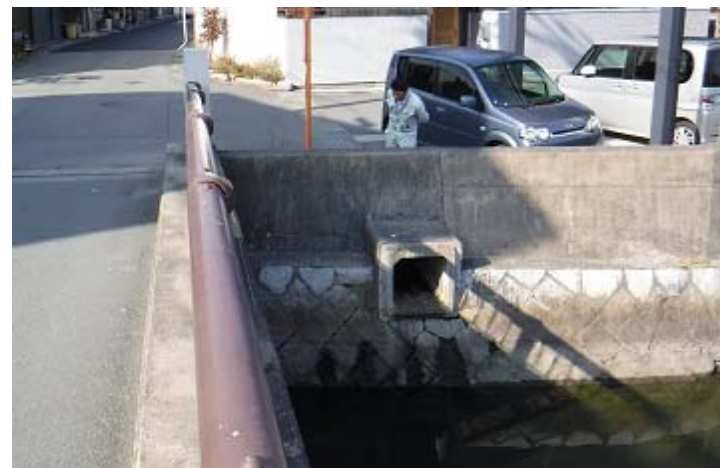
逆流防止フラップ弁設置予定の排水管
