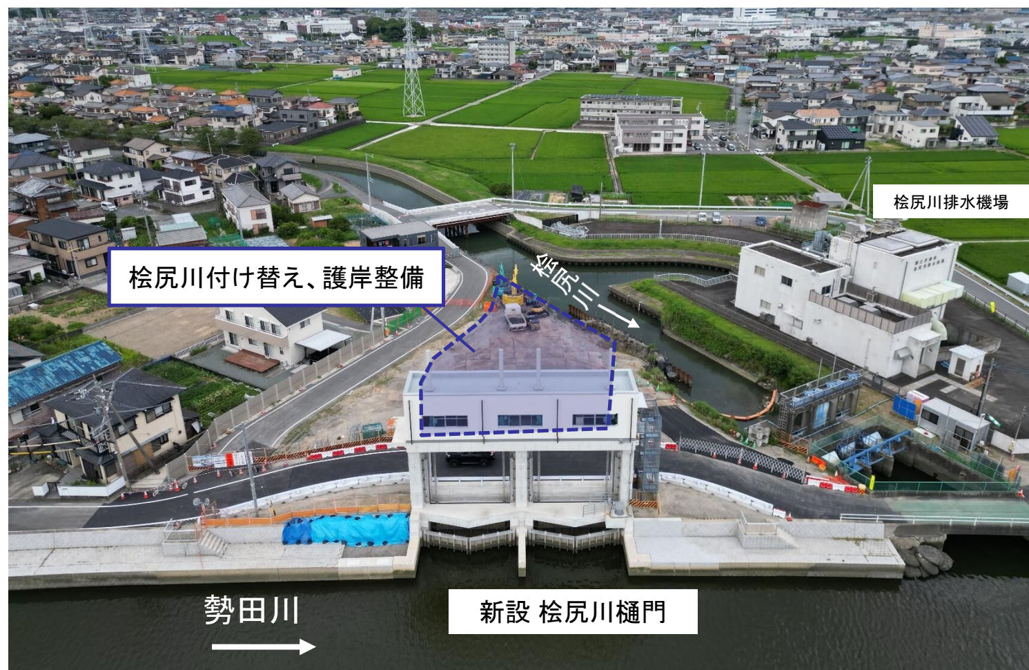
新桧尻川樋門整備の状況(R6.7)
