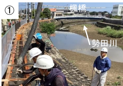
楓橋付近の堤防嵩上げ状況
