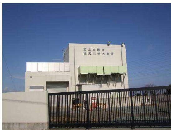
図 2-6 桧尻川排水機場ポンプ増強
