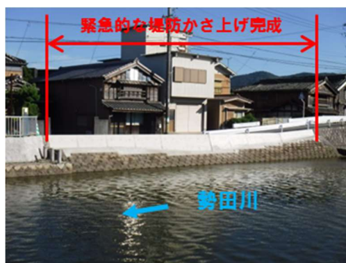
図 2-2 特殊堤防設置状況（北新橋右岸下流）
