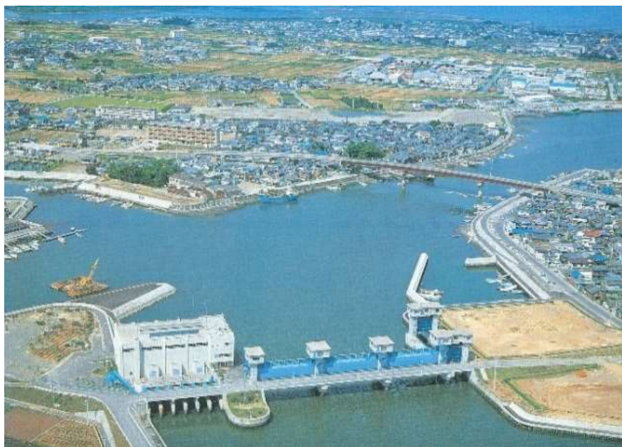
図 2-4 勢田川排水機場ポンプ増強
