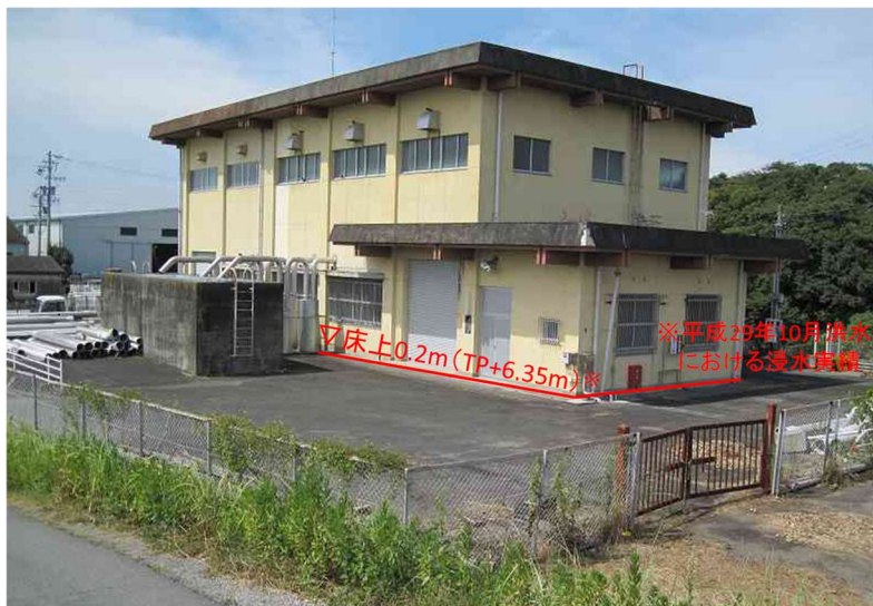
図 3-7 汁谷川排水機場
