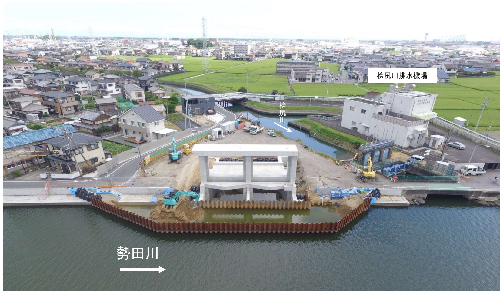
新桧尻川樋門整備の状況(R5.7)
