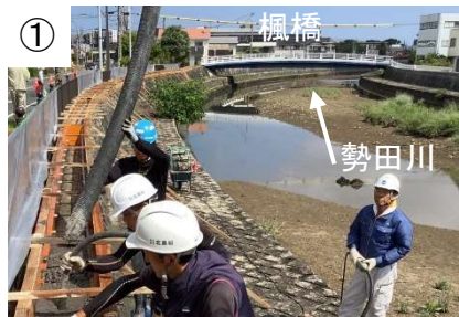
楓橋付近の堤防嵩上げ状況
