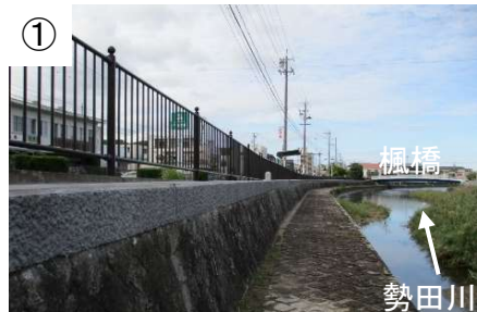
楓橋付近の堤防嵩上げ完成後
