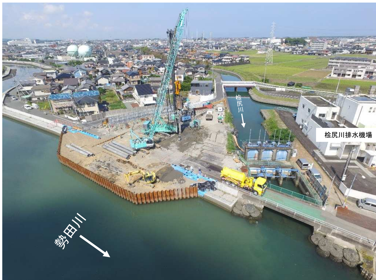
新桧尻川樋門整備の状況(R4.9末)
