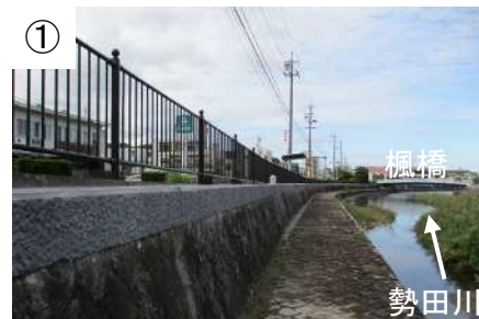
楓橋付近の堤防嵩上げ完成後
