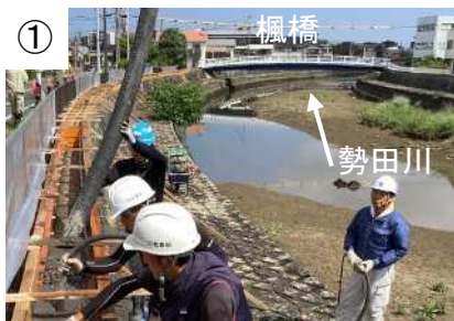
楓橋付近の堤防嵩上げ状況
