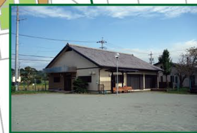
東新村公民館【自治会避難所】
