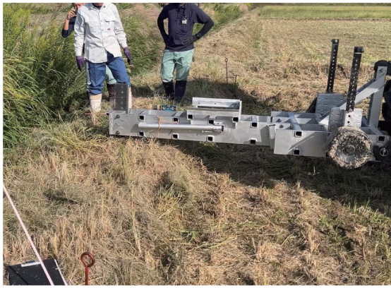
写真 1 落水口新設の様子
