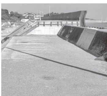
二見地区堤防改築工事の様子
