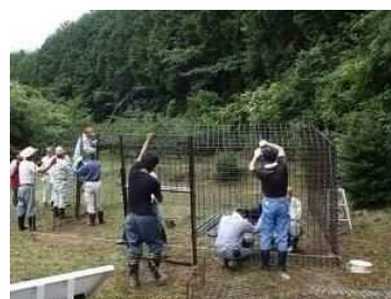
鳥獣被害対策（侵入防止柵の設置）
