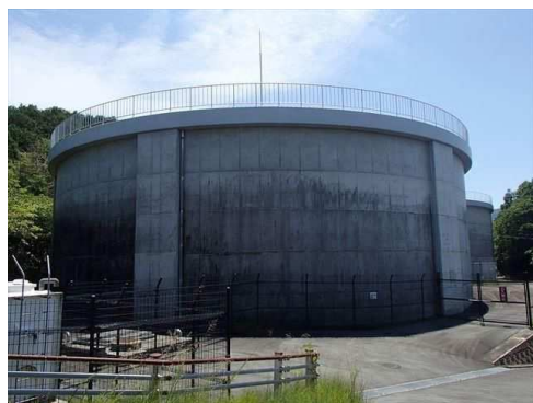
配水場（宮川配水池）
