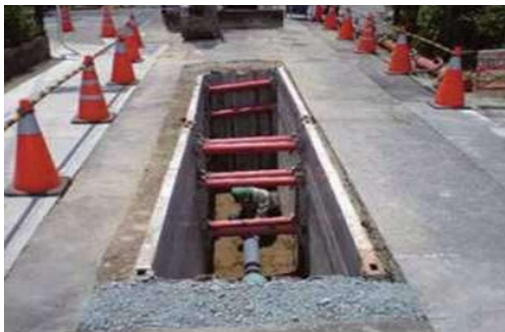
下水道管を埋める様子
