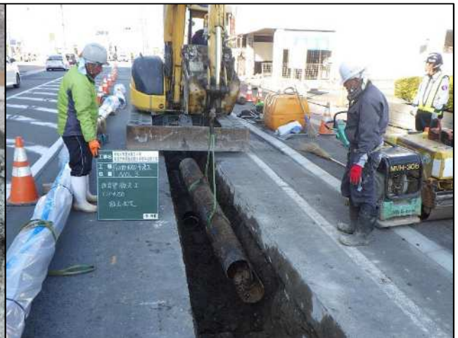
【老朽管撤去状況】
