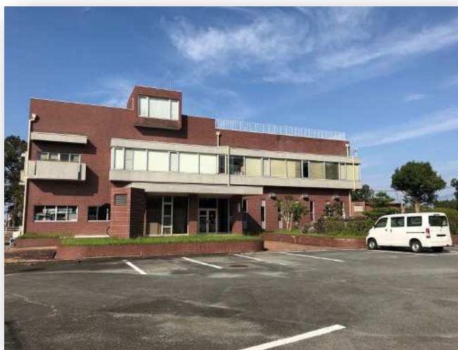
【中須水源地水道管理センター】
