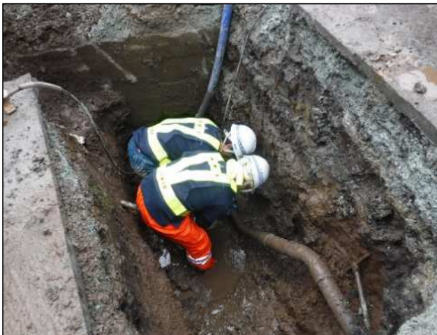
【漏水管修繕状況】
