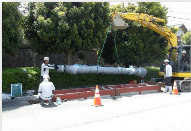
【配水本管布設替工事】
