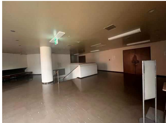
多目的ホール出入口（写真右側）
