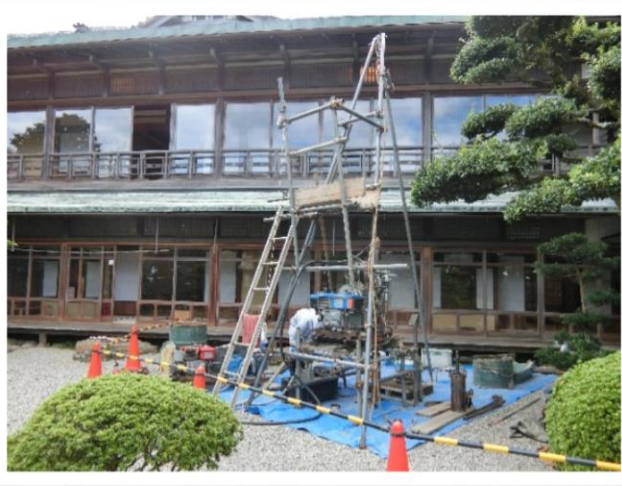
地盤調査の様子
