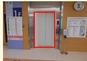
本館・東館 1 階エレベーター扉
