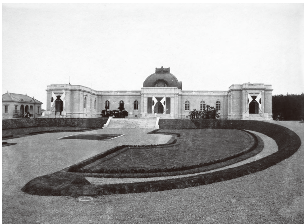
建設当初の神宮徴古館（神宮徴古館所蔵資料より）
