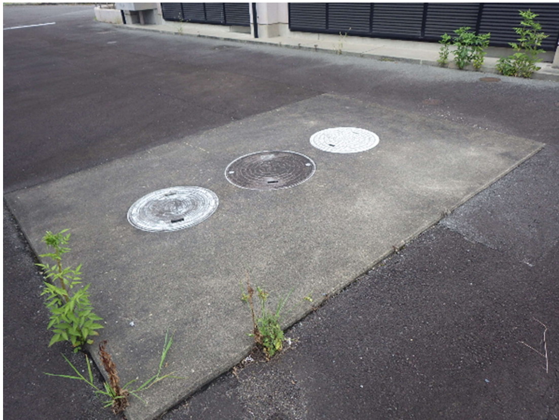
支障物 合併浄化槽（下水道に接続済 内部は解体消毒済）
