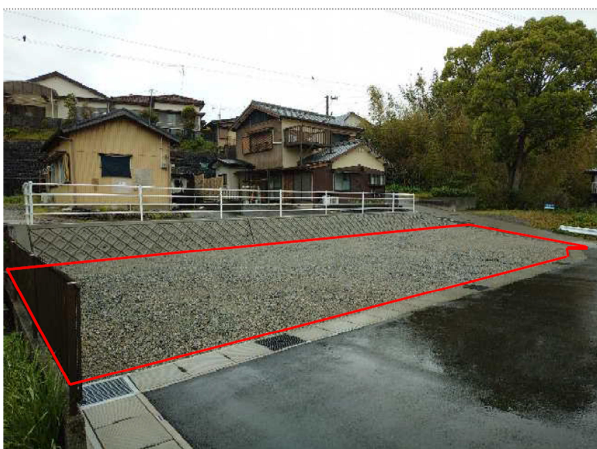
全景(南東側から撮影)
