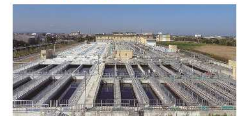
宮川浄化センター
