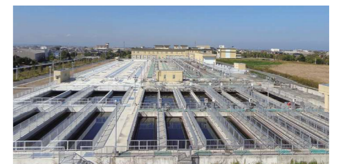
宮川浄化センター
