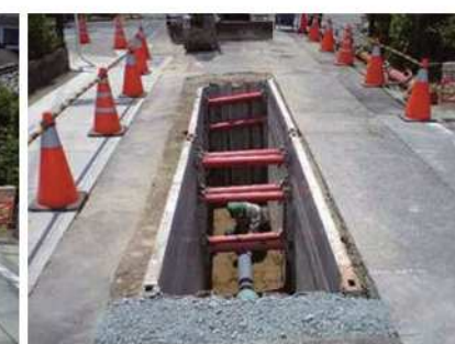
下水道管を埋める様子
