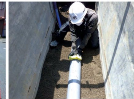
下水道管を埋める様子
