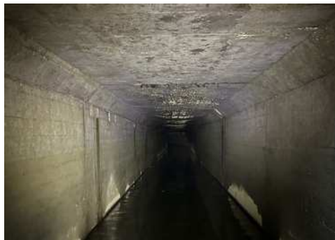
（内面更正 施工前）
