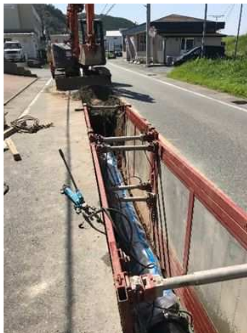
（水道管の敷設替え）
