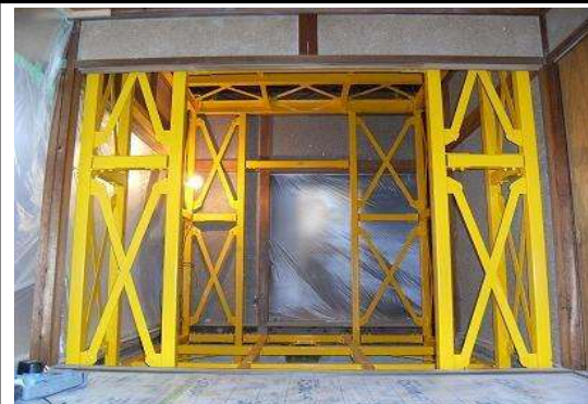
⑧レスキュールーム 有限会社ヤマニヤマショウ 053-442-2420 静岡県浜松市中央区中田島町1451
